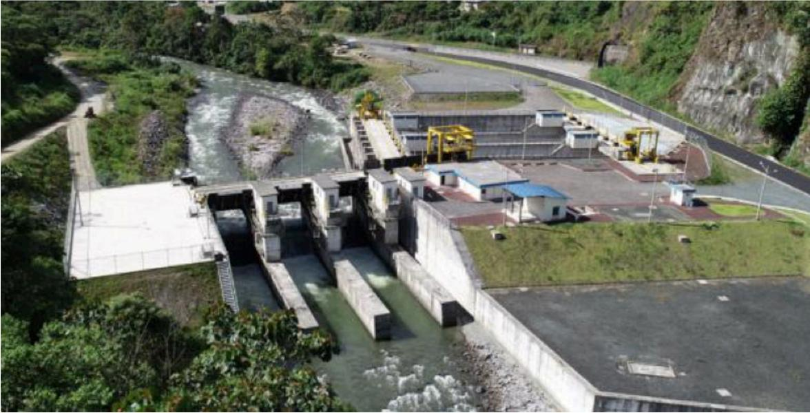
**Figura Nro. 4-31: Captación del río Pilatón, Proyecto Hidroeléctrico Toachi – Pilatón**
