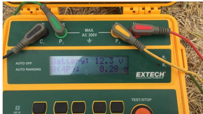
Fotografía 2. Valor medido de resistencia de PT en SE Catamayo, 0.28 \Omega
