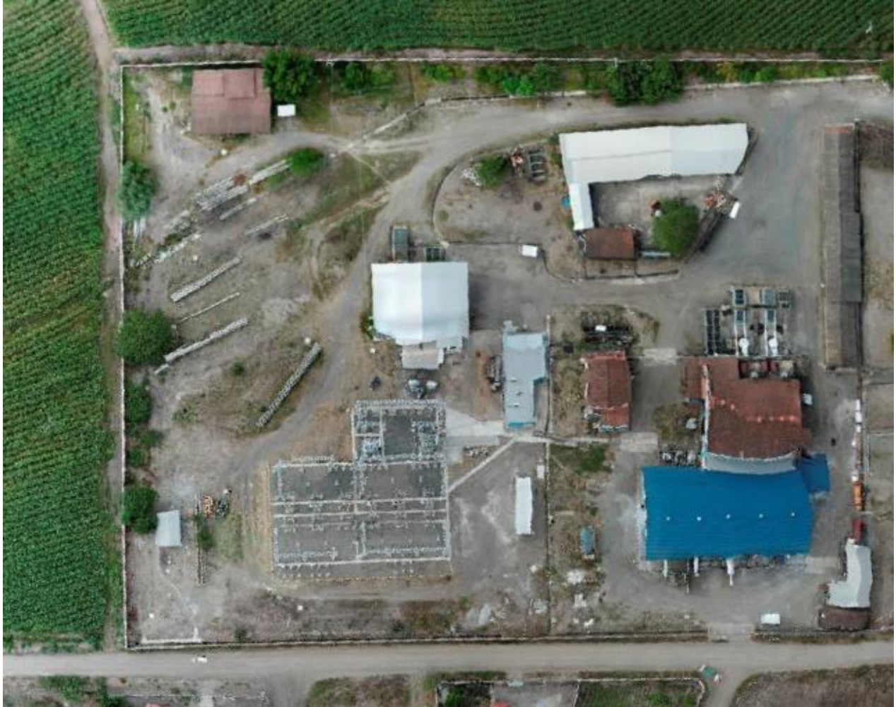
Fotografía 1: Vista actual de subestación Catamayo Fuente: Imagen tomada por el equipo técnico del consultor
